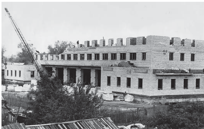
Строительство нового пожарного депо СВПЧ-19.
