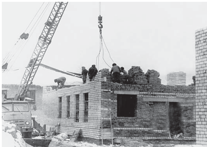
Строительство нового пожарного депо. 80-е годы XX века.
