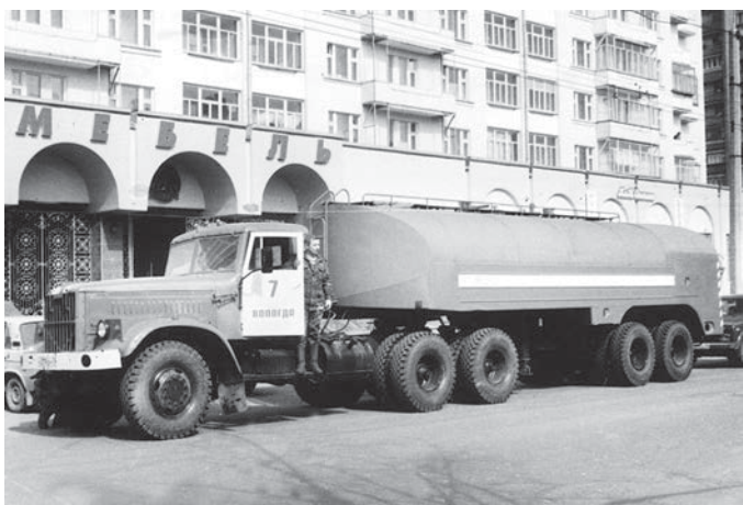
Автомобиль АВЦ-22 (22 куб. м воды) для тушения пожаров в безводных районах Вологды.
